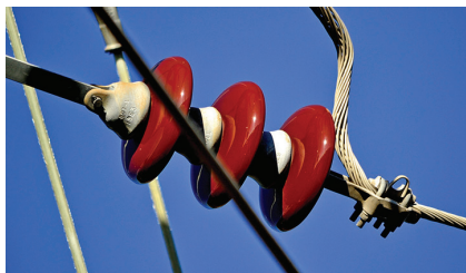
Slika 1.8. Keramički izolator
